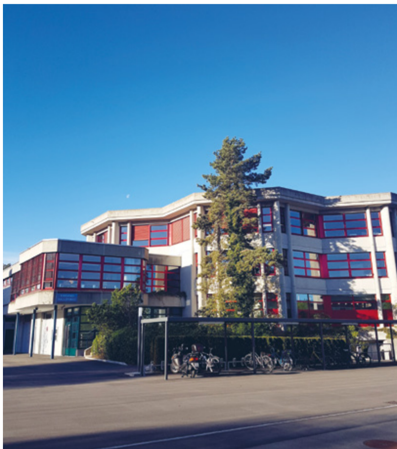
Die Sek Nord ist sanierungsbedürftig.
